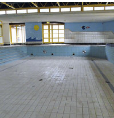
Nicht sanierungsfähiges Hallenbad und ungenutzter Raum sucht eine neue Zweckbestimmung.
