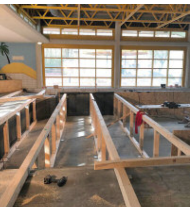
Zimmereiarbeiten für die Konstruktion des Holzständerwerks.
