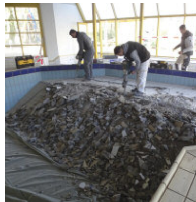
Abriss und Anpassung der vorhandenen Gebäudestruktur.
