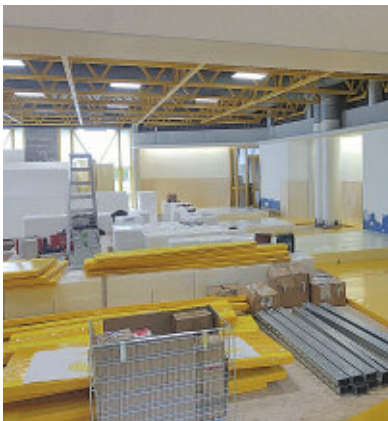
Anlieferung der von BENZ auf Maß angefertigten Bauteile, Schaumstoffblöcke und Matten.
