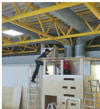
Endmontage der vorgefertigten Teile durch geschultes Fachpersonal von BENZ.
