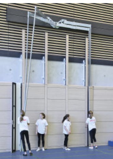
Öffnen der Abdeckungen und Ausschwenken der Kletterstangen
