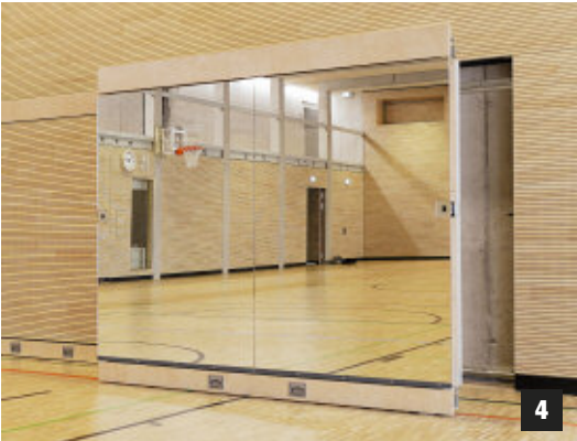
Wandelement ist jetzt 180° gedreht und wird zurück gefahren
