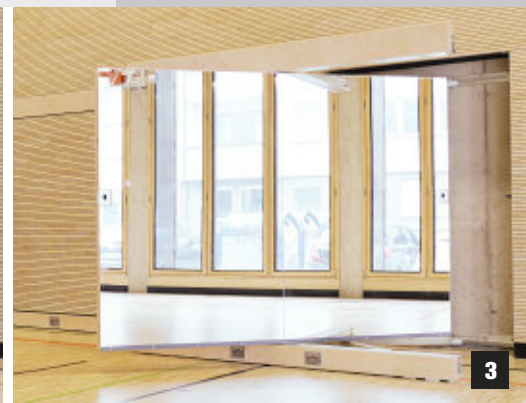
Drehen eines ausgefahrenen Wandelementes
