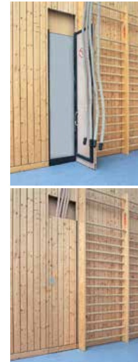
Integrierter Wandkasten in Halle mit bauseitiger Holzverkleidung.
