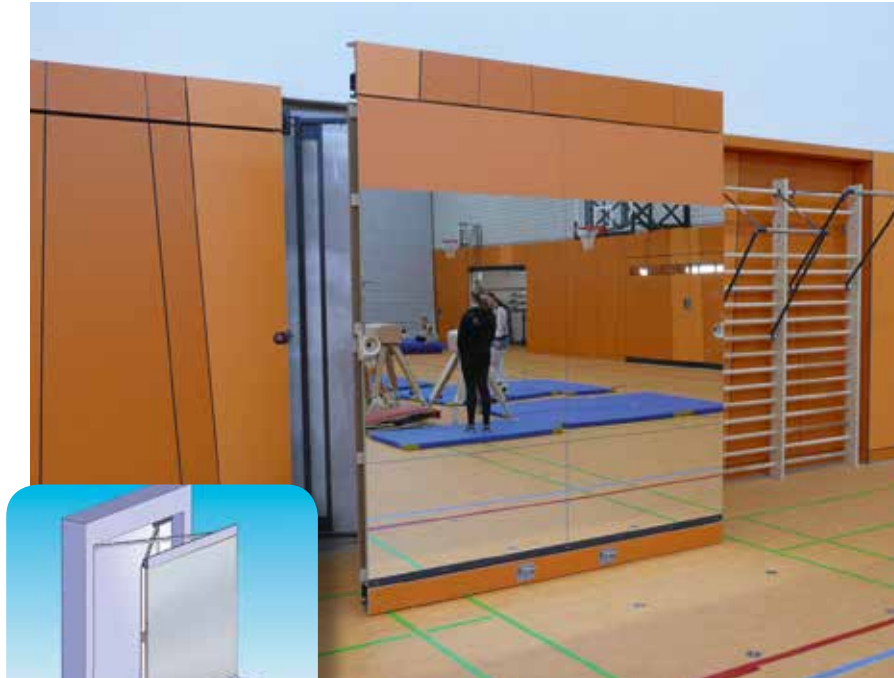
Wandelement ist jetzt 180° gedreht und wird zurück gefahren
