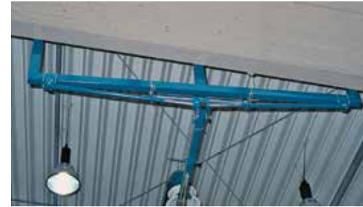
Rohrträger hochgefahren – bei Ballspielen keine störende Konstruktion im Luftraum
